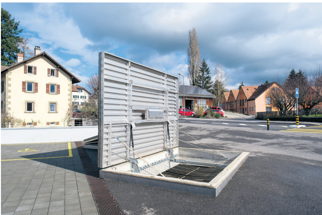
Pour économiser de la place autour du collège d'Oron, les silos où sont stockées les plaquettes sont souterrains.
